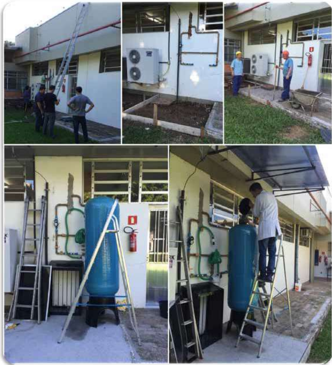
Figura 7 – Imagens do processo de montagem e instalação do sistema de desfluoretação FT3, no Bloco 12 do campus da UNISC em Santa Cruz do Sul, RS.
